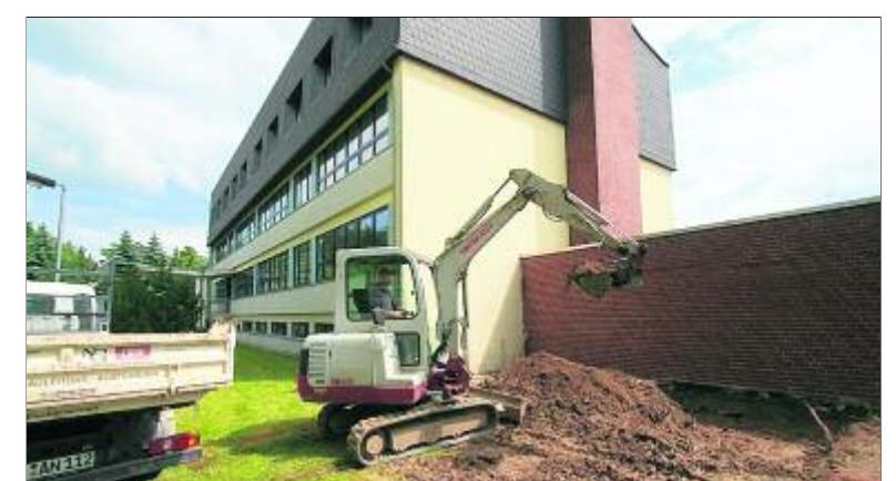
Am Mittwoch rollte der Bautruppan.
